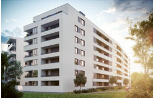
1. Osiedle Mickiewicza ul. Rudzka 9 inwestycja zrealizowana
